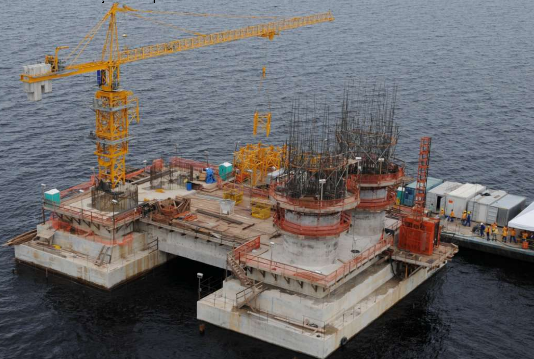
Bloco de fundação do apoio central
