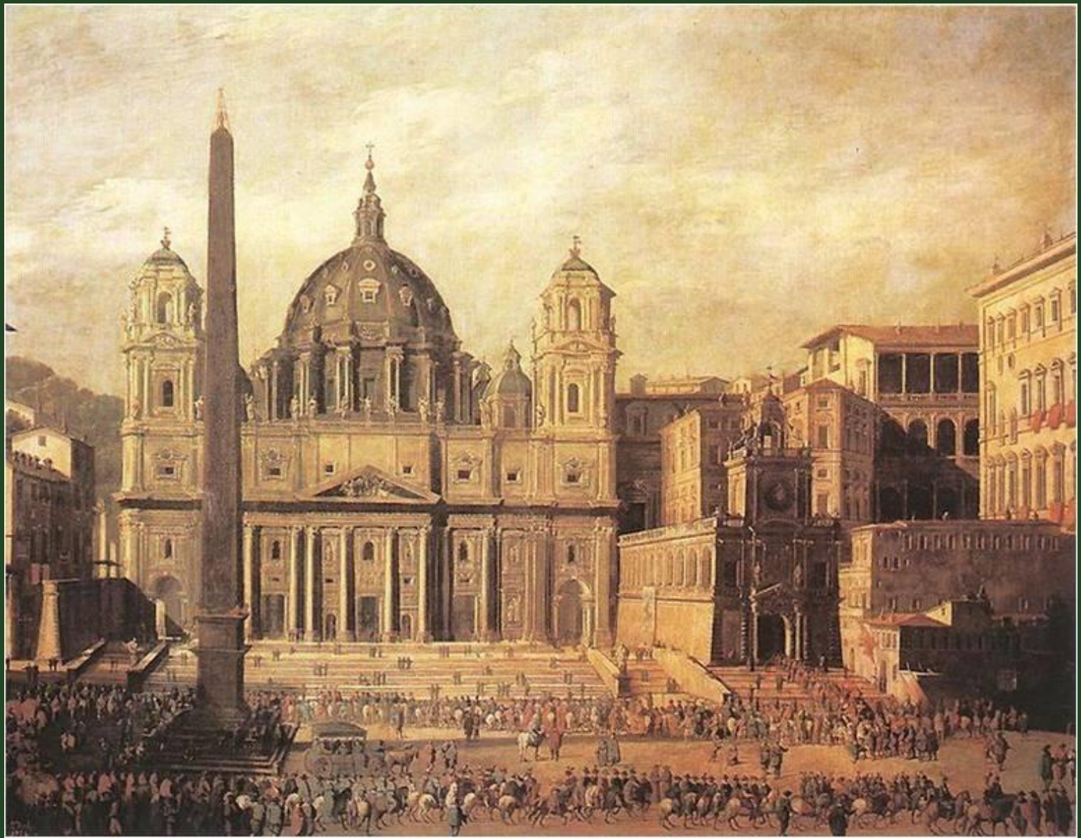
Pintura de 1630. Nota-se os dois campanarios, mais tarde suprimidos.
