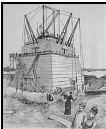
CONSTRUÇÃO DO PEDESTAL JUNHO 1885
